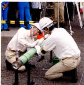
真剣に緊急漏洩修理作業中
